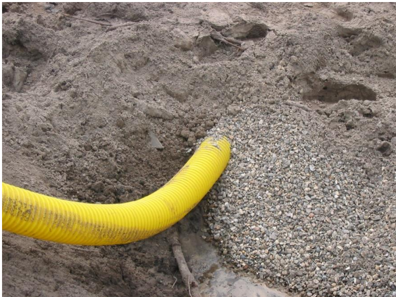
Figuur 15: Voorbeeld van de aanleg van een drain
