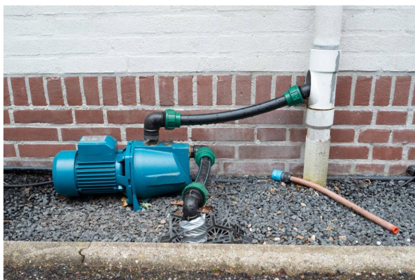
Figuur 1. Particuliere oplossing tegen wateroverlast: een nieuw aangeschafte pomp onttrekt grondwater en loost het op een regenpijp die uitkomt in het riool.
