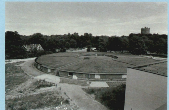
Drinkwaterarchitectuur op het Pompstation Overveen.
