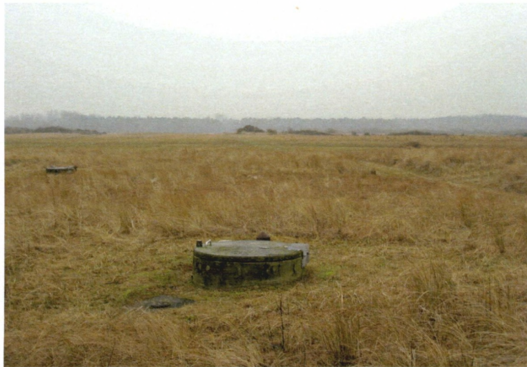
Voor de infiltratie en terugwinning worden infiltratieputten geslagen. Bovengronds is daar weinig van te merken.
