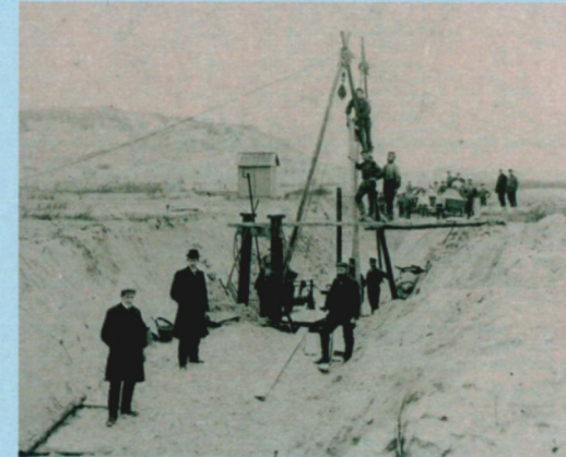
De aanleg van de winweg, de prise d'eau , aan het einde van de 19e eeuw, waar het water op natuurlijke wijze werd gewonnen, eerst met ondiepe winningen en later op grotere diepte.
